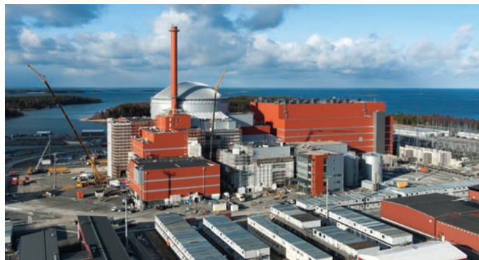
Rys. 4.12 Obudowa bezpieczeństwa (w kształcie kopuły) i budynki odporne na uderzenie samolotu w elektrowni jądrowej Olkiluoto 3, fot. TVO, 19.03.2014.
