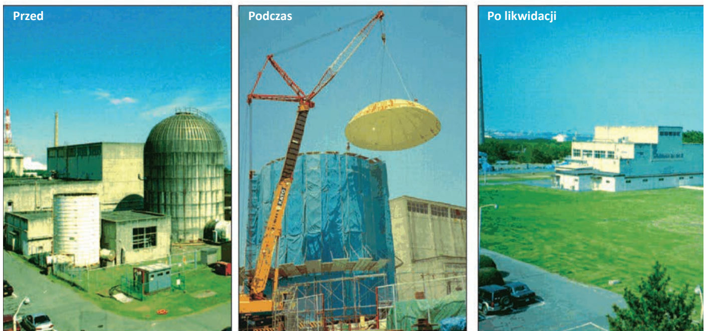
Rys. 3.13 Demontaż japońskiego prototypowego reaktora BWR (NEA 5728).
